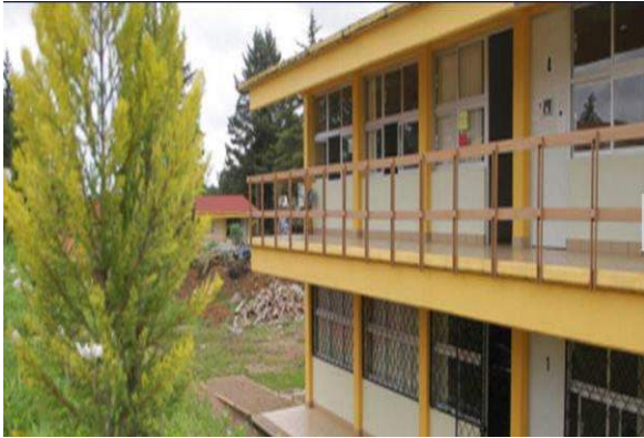
Fotografía: Instalaciones del Campus Amealco.
